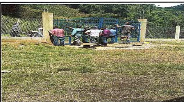
Foto 4: COLOCACIÓN DE PORTON
