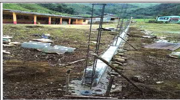
Foto 2: LEVANTAMIENTO MURO PERIMETRAL
